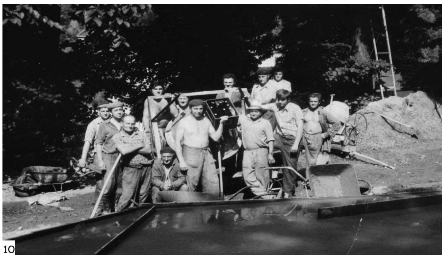
1975 stavba parketu v Kandlerové skále
